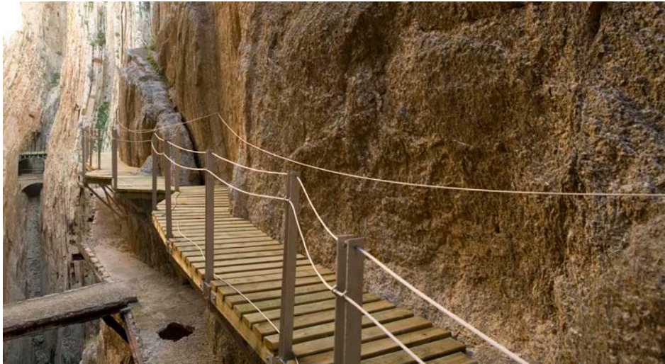
Trabajos de sustitución de la estructura original por la nueva pasarela. En la imagen superior, los dos caminos coexistiendo.
