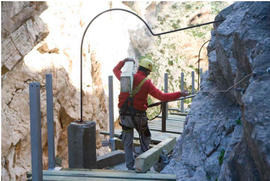
Trabajos de sustitución de la estructura original por la nueva pasarela. En la imagen superior, los dos caminos coexistiendo.
